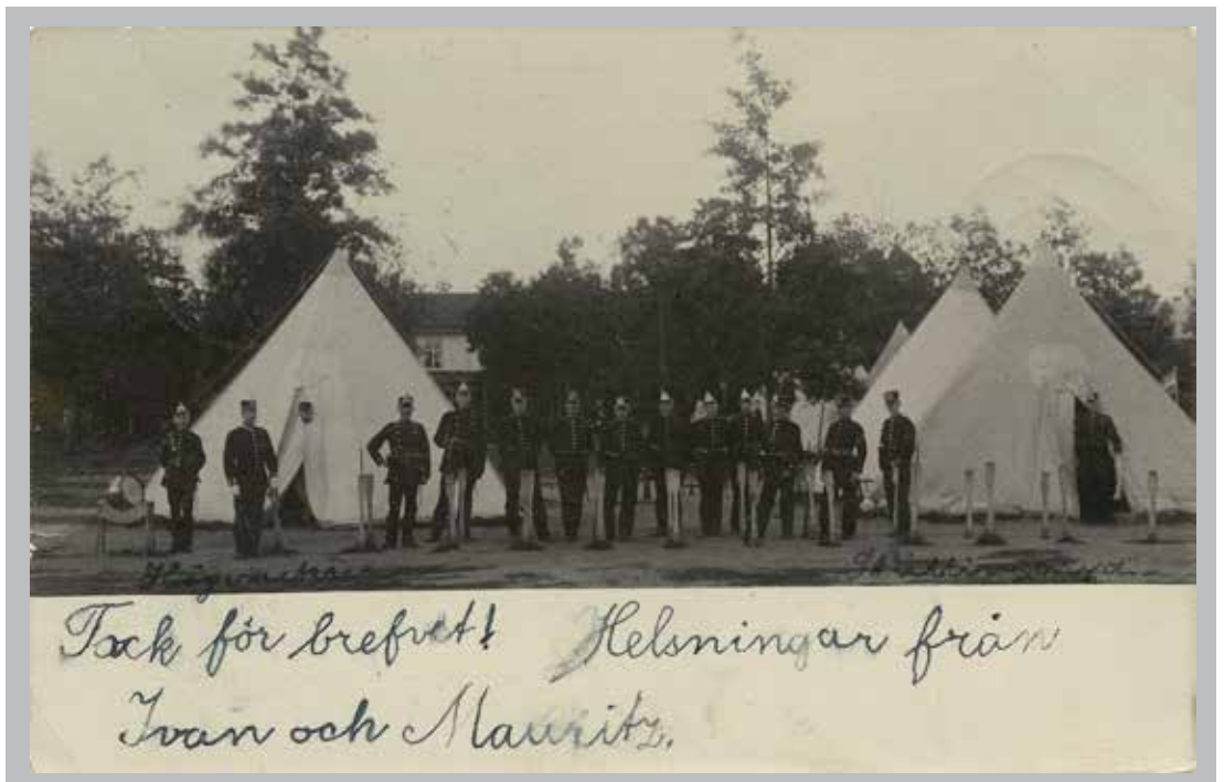
Högvakten Skillingaryd. Tälten står precis framför Mässen – byggnad 146.
